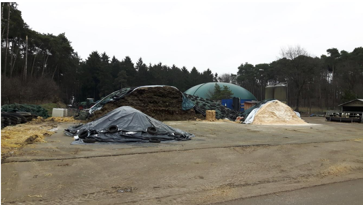
Abb. 1: Baulicher Bestand im Änderungsbereich
